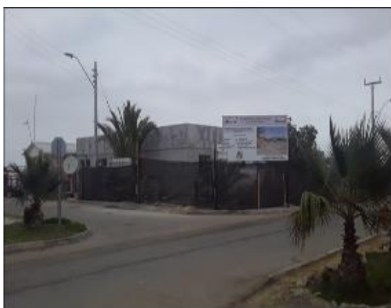
Fotografía, PSR Carrizalillo, recinto provisorio mientras se realiza la ejecución "Proyecto Reposición Posta Carrizalillo".
